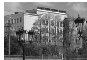
620075, г. Екатеринбург, ул. Карла Либкнехта, д. 42
