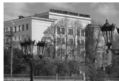
620075, г. Екатеринбург, ул. Карла Либкнехта, д. 42
