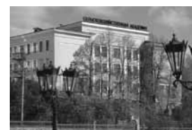
620075, г. Екатеринбург, ул. Карла Либкнехта, д. 42
